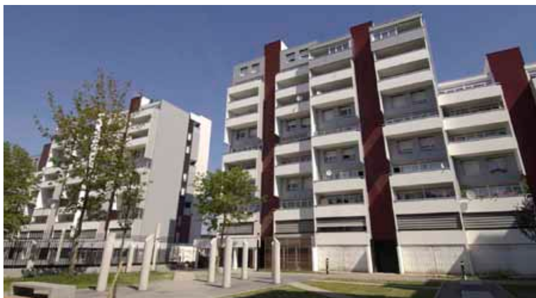
LA CITÉ ALLENDE RÉHABILITÉE À VILLETANEUSE – © S. CHAMBERT
